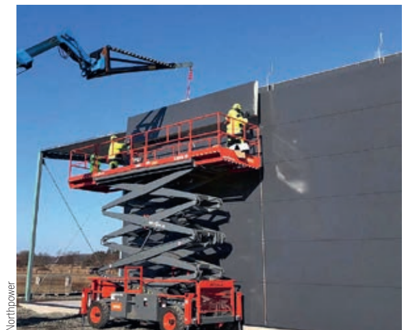
Smidigt montage av sandwichväggar.
