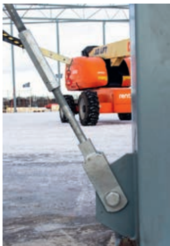
Infästning av dragslag i stålstommen.
