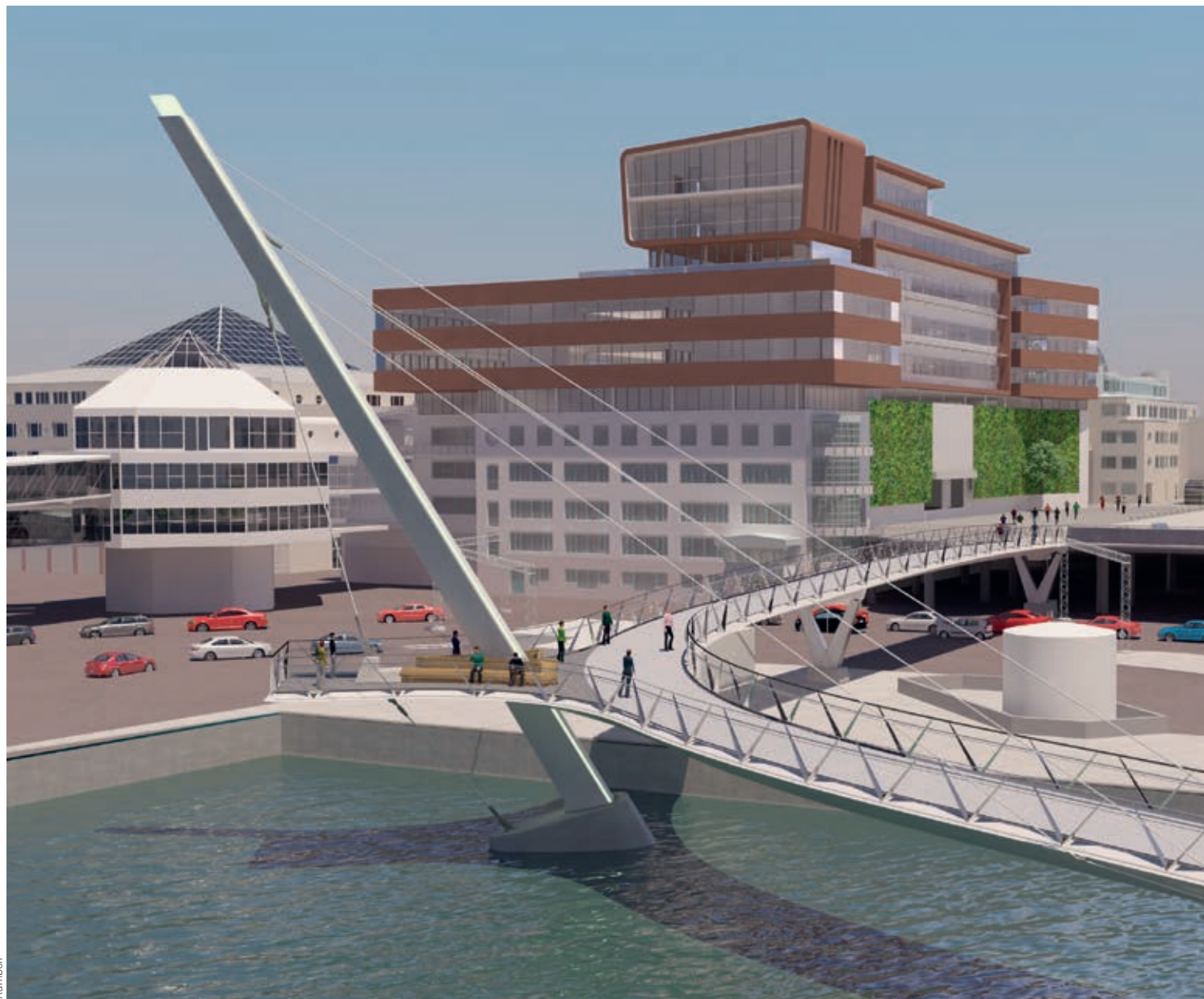
Bild 2. Den drygt 200 m långa bron svingar sig elegant från Knutpunkten över hamnbassängen via parken "Dockan" till Oceanpiren och bärs upp av tre kraftiga kablar som sveper runt brobanan från två pyloner i ytterkurvorna av S-formen.
