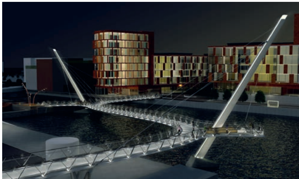
Bild 4. Ljussättningen av brobanan sker från punktbelysning i handledarna, men effektbelysning ska installeras både vid foten och i toppen av respektive pylon. Dessutom finns slitsar i pylonens alla hörn, i vilka längsgående ljuslister kommer att placeras och på toppen av pylonerna står akrylkupoler som ska lysas upp av två armaturer från insidan.
