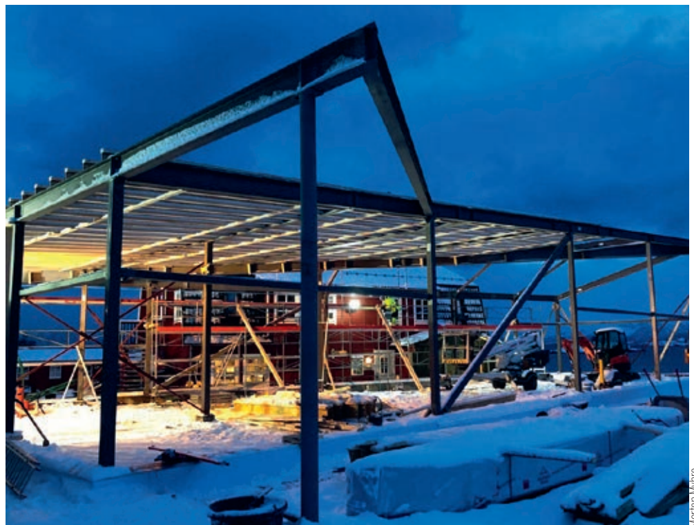
Restaurantbygget under oppføring
