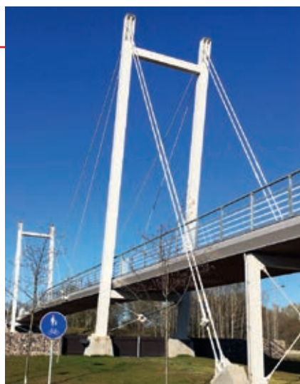
Figur 1: Pilonbron i Kalmar är tillverkad med standardsvetsprocedurer.
