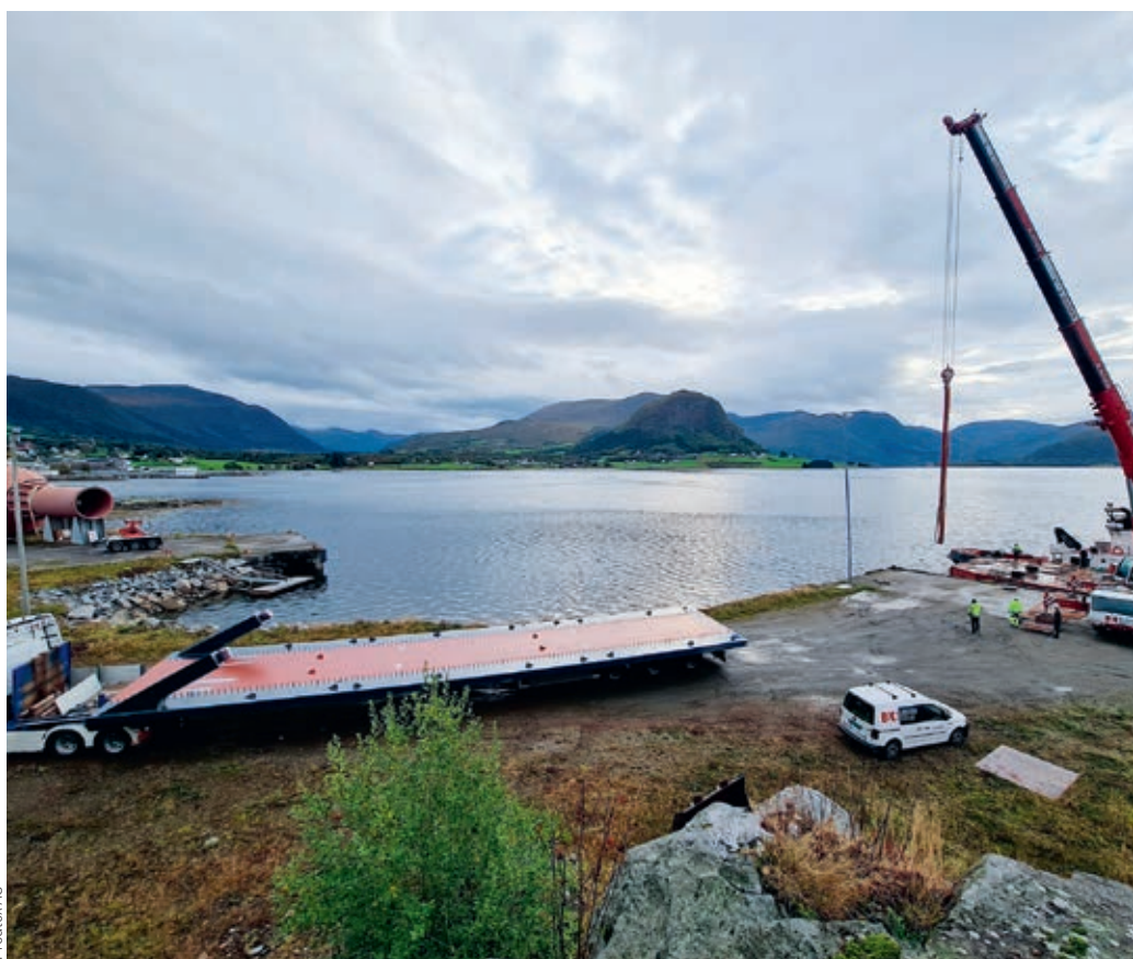
Her er verdens første brudekke som er sveiset ved hjelp av automatisert lasersveising klar for transport fra Vanylven på Sunnmøre til Åfjord i Trøndelag.
