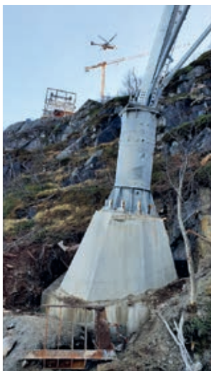
Mastefundament direkte forankra til fjell.
