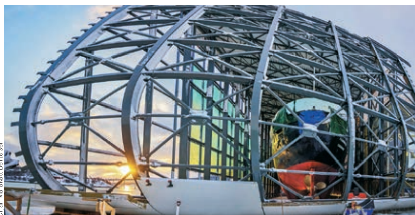
Gavlvegg med «spant» og vindkryss
