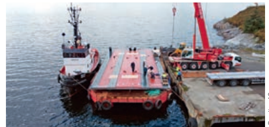
Brudekket er lastet på lekter og er klart for transport til Åfjord kommune.
