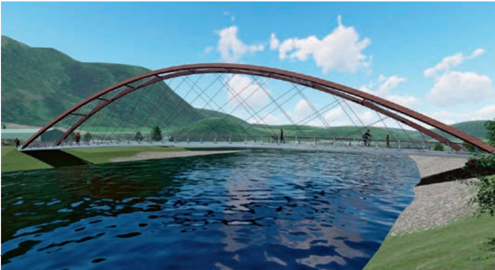
Frønes gang- og sykkelveibru blir verdens første lasersveisede bru.
