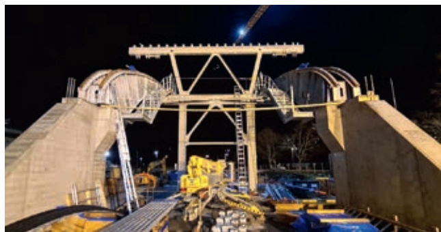
Sadlar montert på betongpullertar i botnstasjon.
