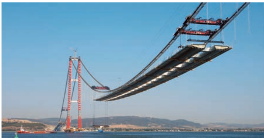
Figur 15: Montage af dæksegmenter ved hjælp af løstekraner monteret på hovedkablerne, montagen foregår tilnærmelsesvis symmetrisk
