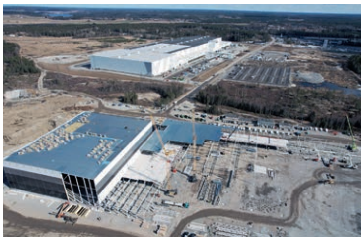
Stommontering pågår i början av april.
