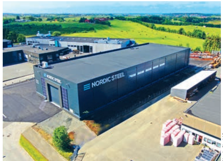
Den nye sveisehallen er 30 x 84 meter lang og 13 meter høy, med porter på 8 x 8 meter, og har vannbåren varme i gulvet.
