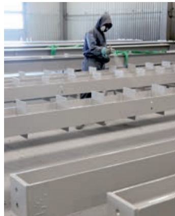
Här lackeras stommarna till aktuell korrosionsklass.
