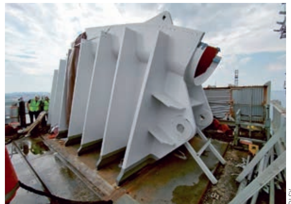
Figur 10: Tårnsadel i kombineret stål og støbegods ses monteret på tårntoppen
