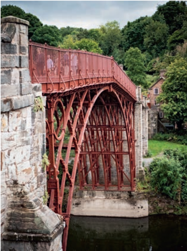
Iron bridge: Material: Gjutjärn Längd: 30,6 m Ingenjör: Abraham Darby III Byggår: 1779 (öppnad 1781)
