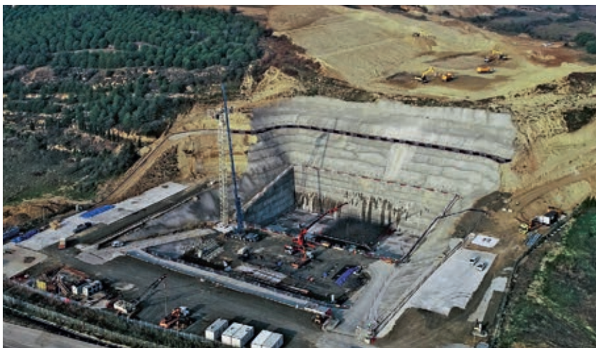
Figur 12: Udgravning til den Europæiske ankerblok
