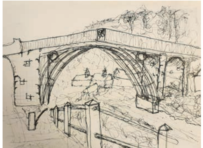
Iron bridge: Material: Gjutjärn Längd: 30,6 m Ingenjör: Abraham Darby III Byggår: 1779 (öppnad 1781)
