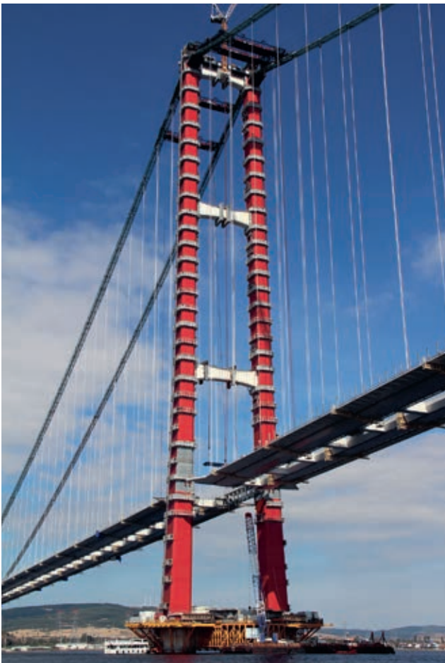
Figur 8: Færdigmonteret tårn med svejseplatforme som indikerer blokhøjder, en samling mellem blokke er vist til højre
