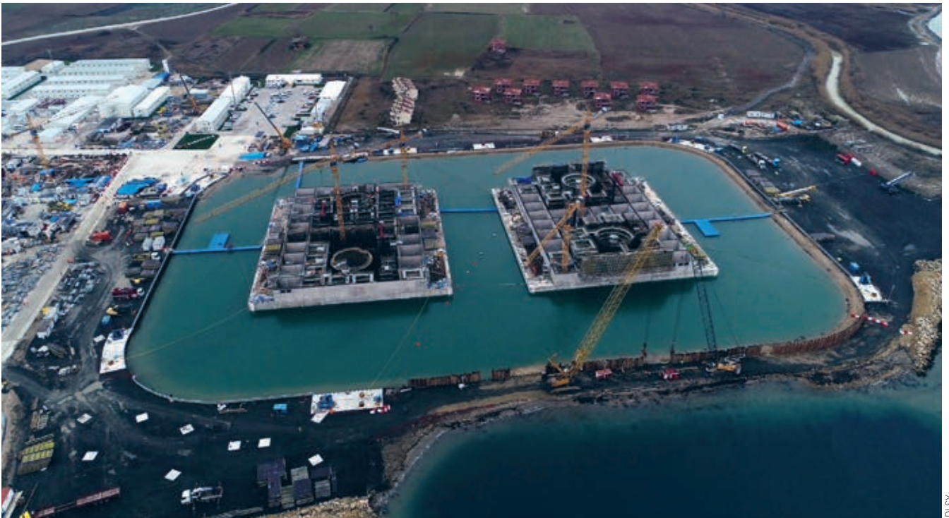
Figur 4: De 2 sænkekasser flydende i den oversvømmede tørdok
