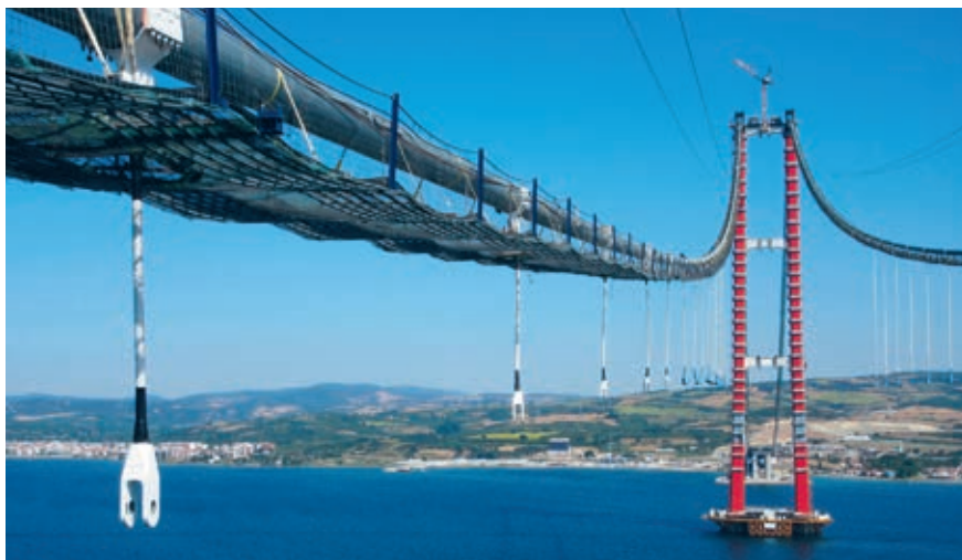
Figur 14: Monterede hængere klar til montage af dæk segmenter
