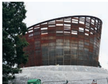
Rundt vannmagasinet er det en stål-skjerm av Corten-stål.
