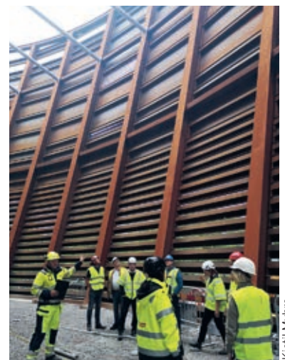
På innsiden av vannmagasinets stål-skjerm av Corten-stål.
