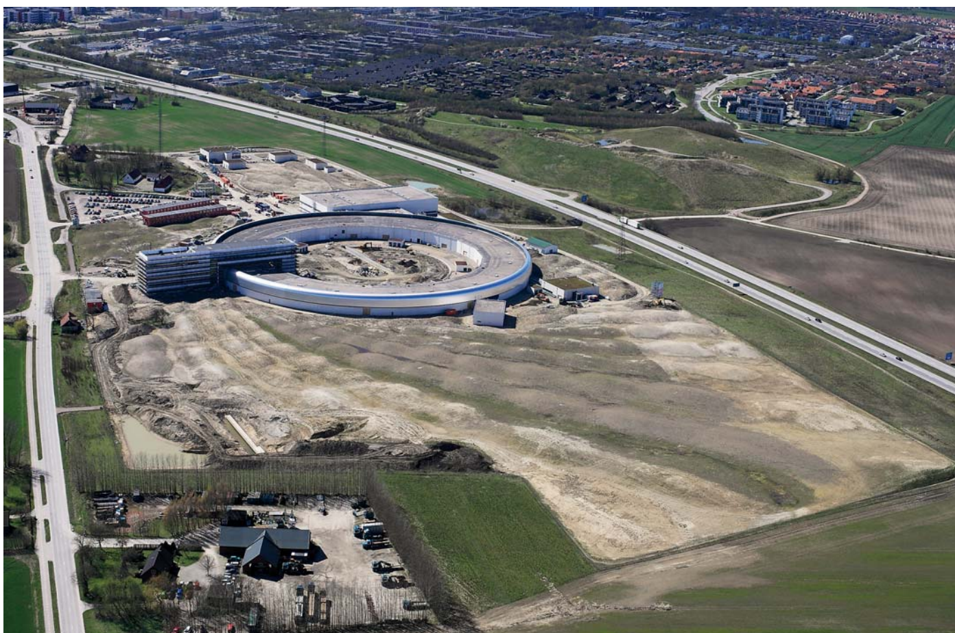
MAX IV - Sveriges genom tiderna största infrastrukturprojekt inom forskning – intressanta stålstommar och plåtfasader.
