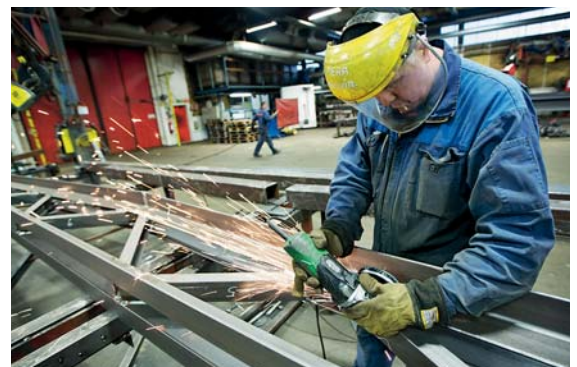
Mats Karbin jobbar med ett stålfackverk, 8 meter långt. Fermeco producerar fackverk som har en spännvidd på mellan 5 och 72,5 meter.
