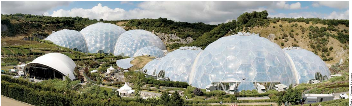
Takkonstruksjonen er lettere enn vekten av luften innenfor.
