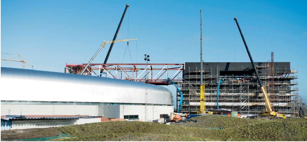
Såväl den runda experimenthallen och den intressanta kontorsbyggnaden har en speciell stålstomme.
