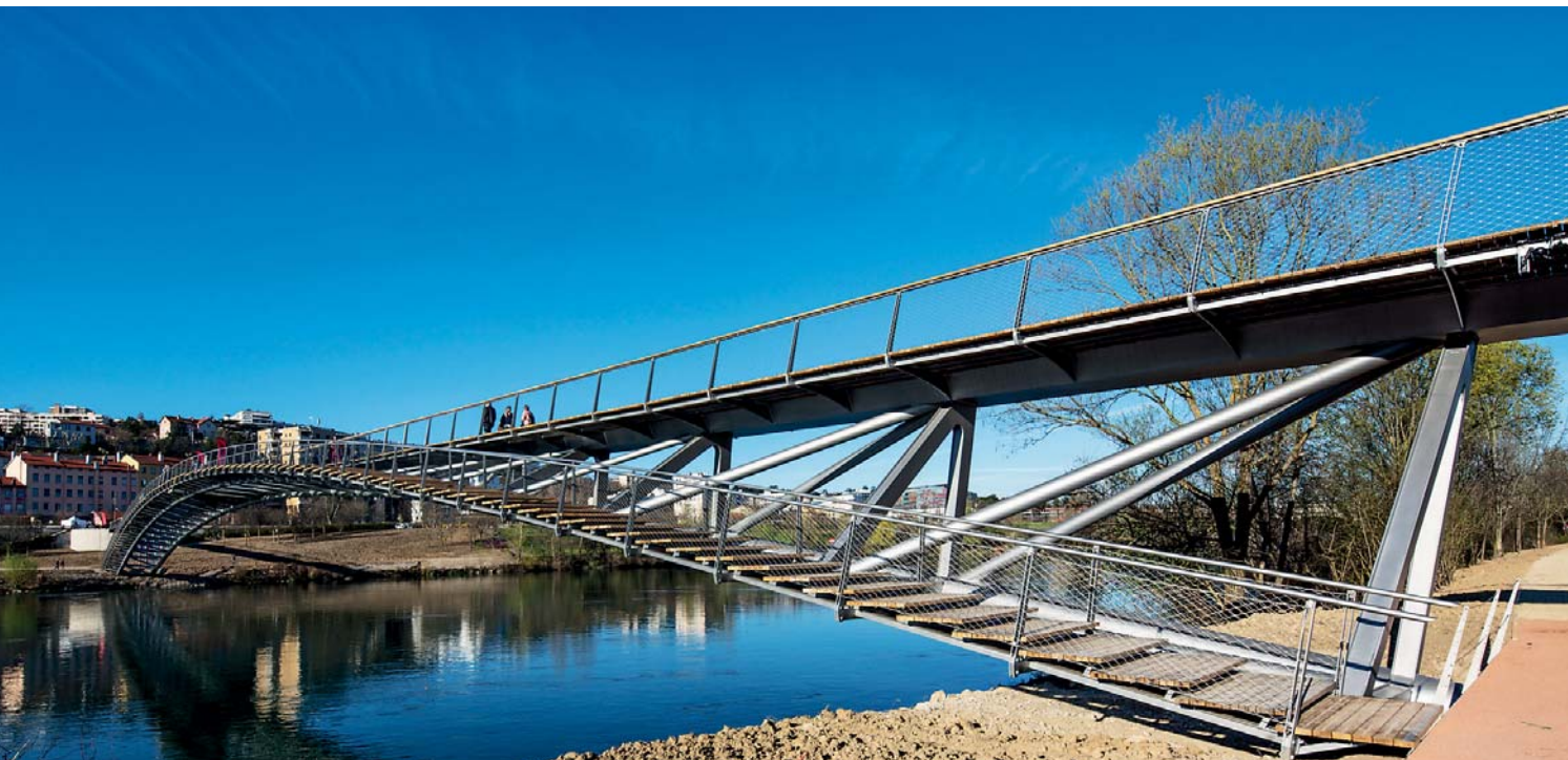
Stålbros Passerelle de la Paix krysser elva Rhône i et enkelt, 160 meter langt spenn.
