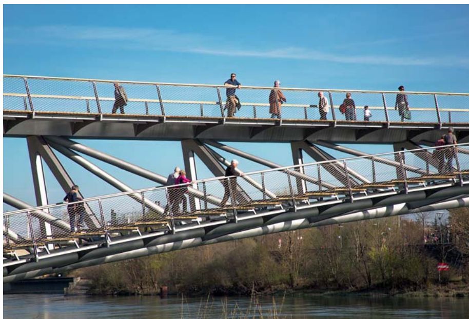
Den spesielle fagverksbroa gir gående to måter å krysse elva på: langs den buede trappen eller rett frem langs overgurtene.
