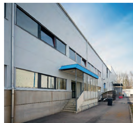
Tepe hade en väl fungerande plåtfasad men valde att renovera sitt kontor med en tilläggsisolerande så
