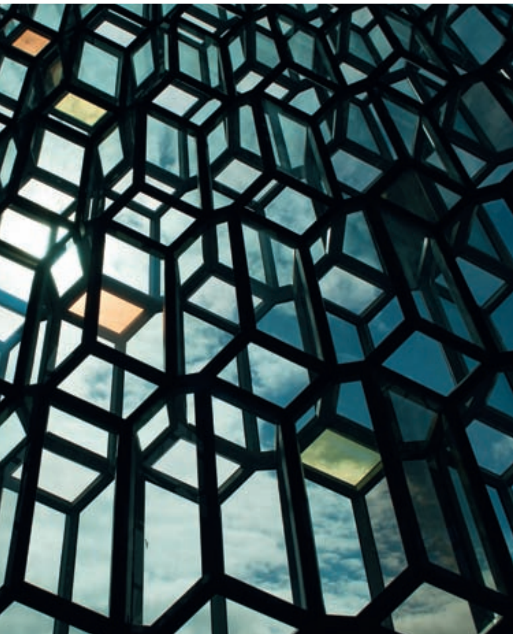
Kvasi-kubene er satt sammen av 24 biter med firkantrør og 18 hjørner i støpestål. Fasaden består av nesten 18 000 hjørner.
