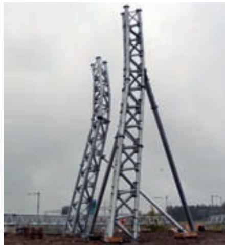
Ovan t.v. provmonterar man stolpen mot fundamentet. Den monterades sedan ner och plåtarna monterades på innan man som på bilden t.h. monterar stolpen.
