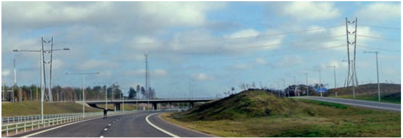
I fotomontaget ovan ser man det något modifierade förslaget från No Picnic där den norra stolpen även sattes på den södra sidan av vägen.
