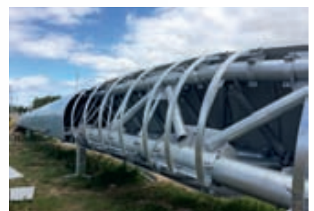
Plåtarna på fackverket monterades med fackverket liggande på marken.
