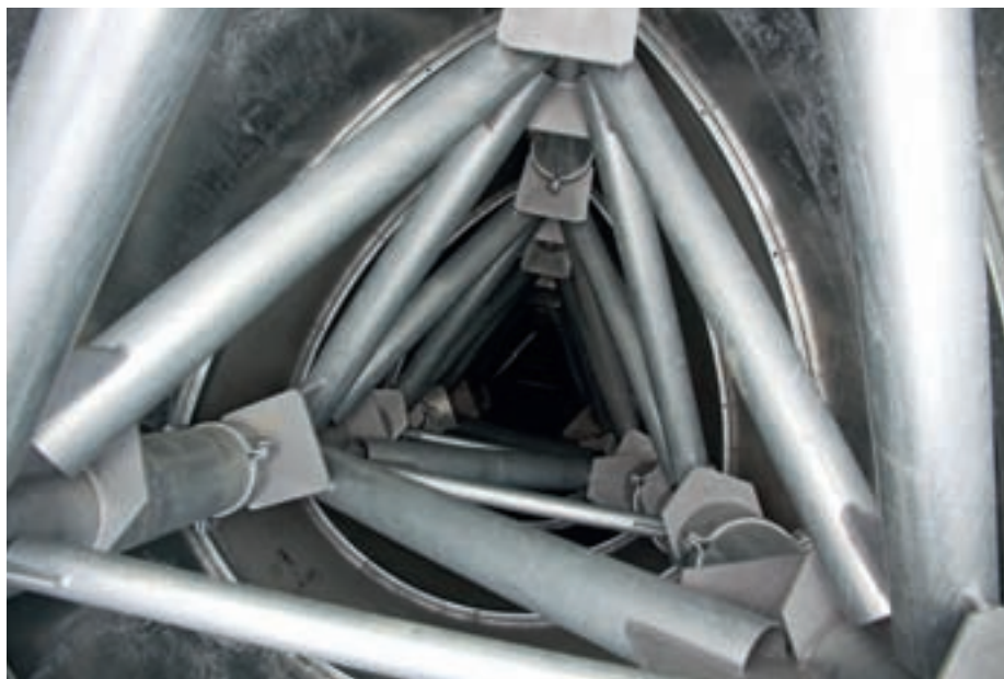
I det inre av Yggdrasil. Stolpens bärande struktur är ett triangulärt fackverk uppbyggt av runda konstruktionsrör.
