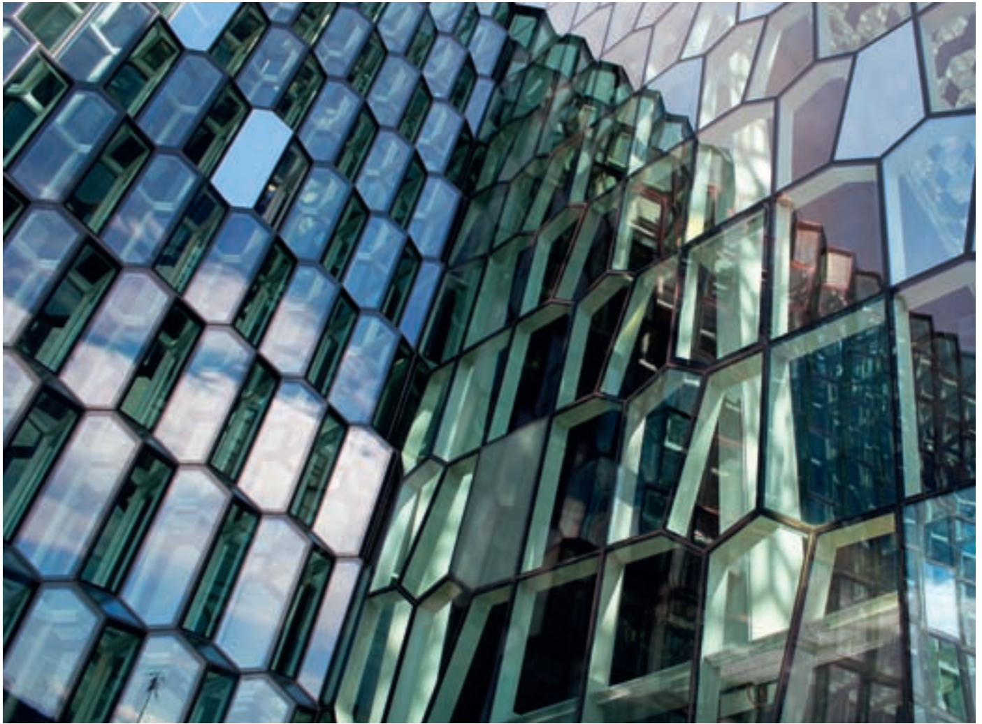
Opprinnelig skulle alle veggene bestå av de romlige kvasi-kubene, men det ferdige designet har både romlige og 'flate' glassvegger. Variasjonene reflekterer himmelen, lyset og bygget selv.
