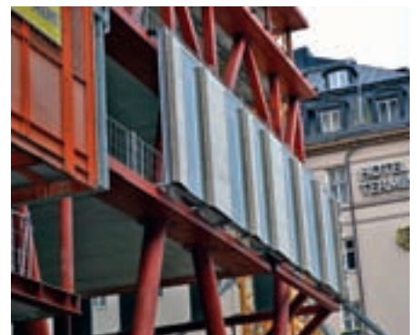
Montaget av fasadelementen är i full gång på Stockholm Continental.
