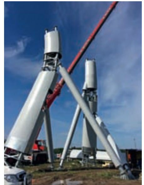
Ovan t.v. provmonterar man stolpen mot fundamentet. Den monterades sedan ner och plåtarna monterades på innan man som på bilden t.h. monterar stolpen.
