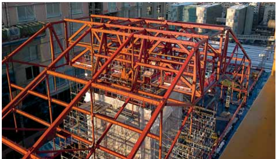
Stålkonstruksjonen i boligdelen av DNB bygg B, Björvika.
