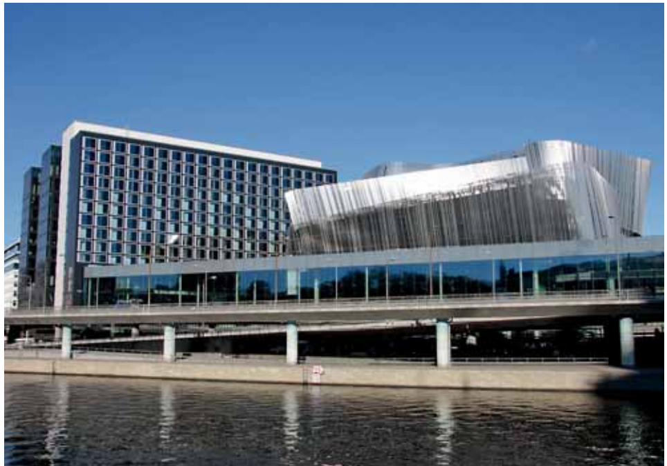
I Stockholm Waterfront används ett modernt energisystem för att flytta värme och kyla dit den behövs för stunden. Kontorshuset och hotellet kompletterar här varandra mycket väl där hotellet har ett litet behov av värmekyla dagtid samtidigt som kontorshuset har störst behov.
