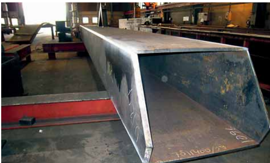
Delar till huvudfackverket till Stockholmsarenan i Normeks verkstad i Uleåborg.
