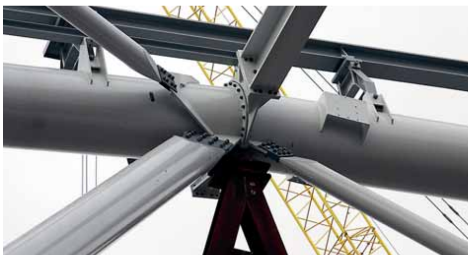
Knutpunkt i ett av takfackverkan till Swedbank Arena i Solna.
