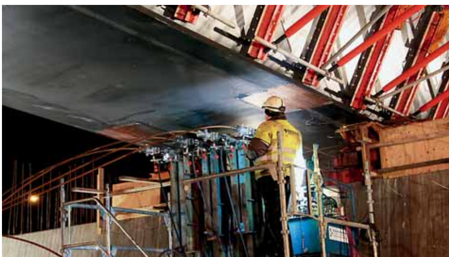
Lansering av brokonstruktionen över E4 vid Kista. Domkrafter som "drar" ställådan medan trafiken på E4 flyter på som vanligt.
