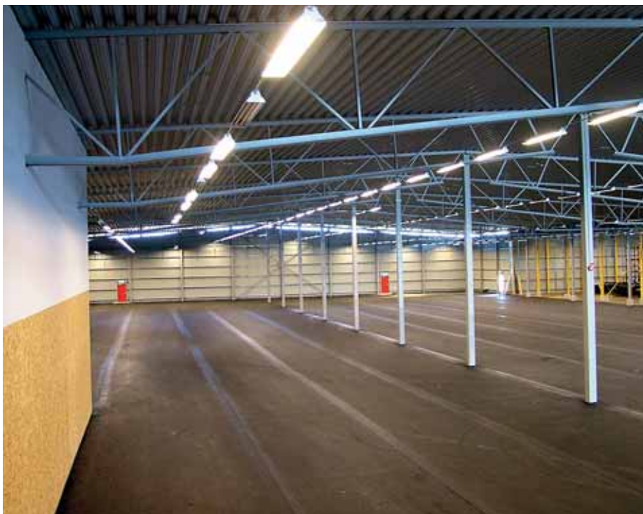
Lätt hallbyggnad stabiliserad genom skivverkan i tak.
