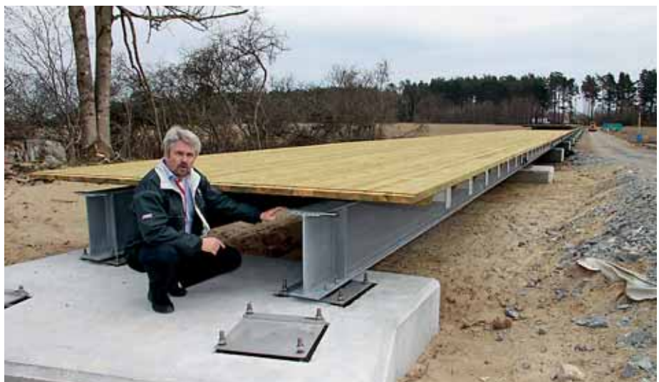
Ronny Södergren förevisar änden på den första etappen av Sölvesborgsbron som består av 12 meter långa sektioner som tillverkas i verkstaden och lyfts på plats med egen personal.
