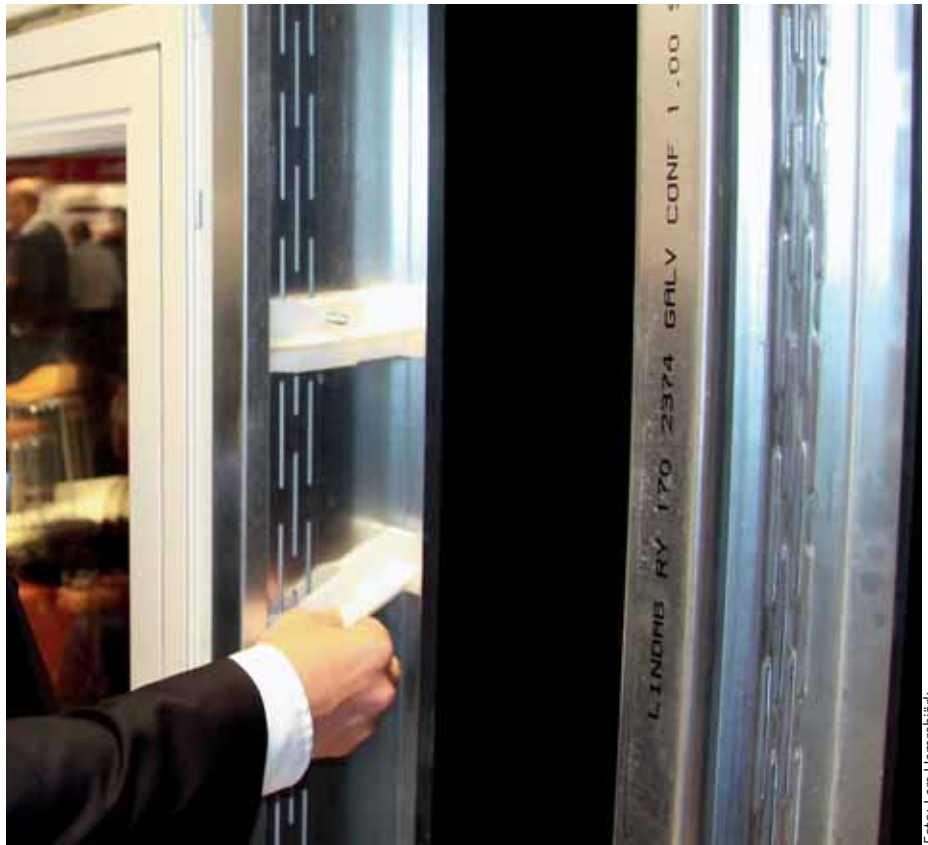
En liten plastkloss monteras på regelns baksida där fönsterinfästningen ska göras.
