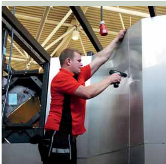
Stommen till Gruvan kläddes med såväl slät som perforerad plåt.
