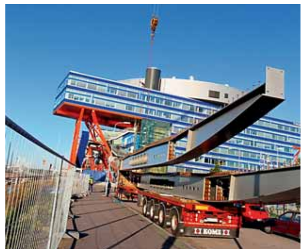
Tvärbalken lyfts på plats
