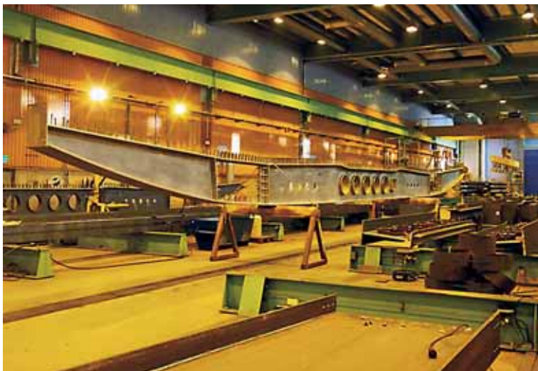
Tvärbalken ihopmonterad på verkstaden.
