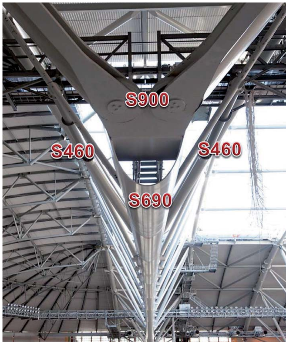
Med höghållfasta stål kunde vikten på det fasta taket till Friends Arena i Solna minskas från 4 584 till 4 000 ton.
