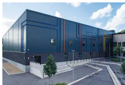
Bild 2. Horisontellt monterade paneler direkt mot fasadpanelerna.
