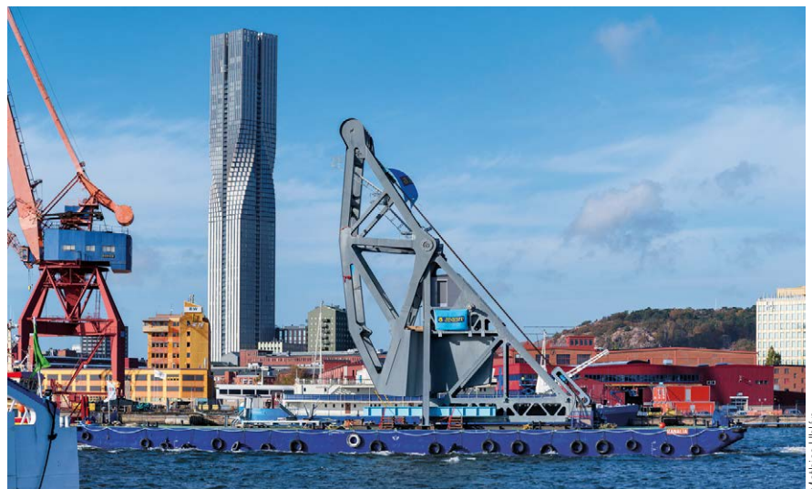
➤ Transport av tornet på pråm genom Göta Älv.
