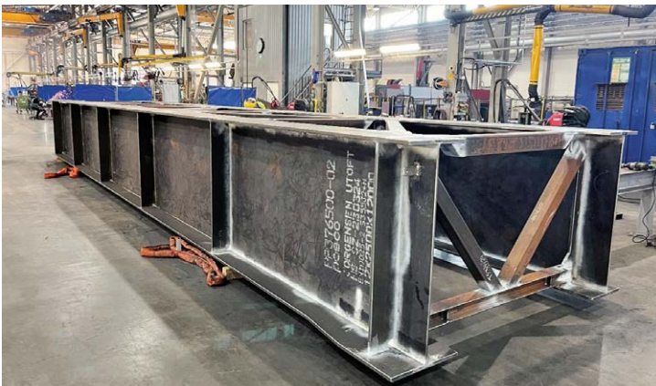
Östra tillfartsbron under tillverkning i Lecors verkstad.
