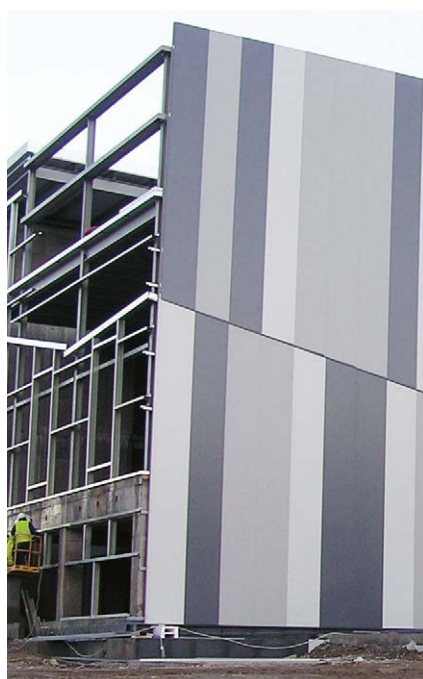
Bild 1. Vertikalt monterade paneler på sekundärstomme.
